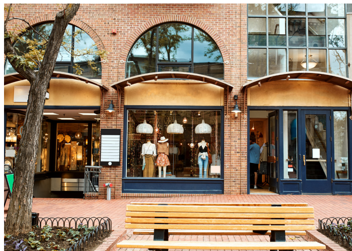
Articulation d'une façade avec un rythme vertical de baies, fenêtres et auvents
