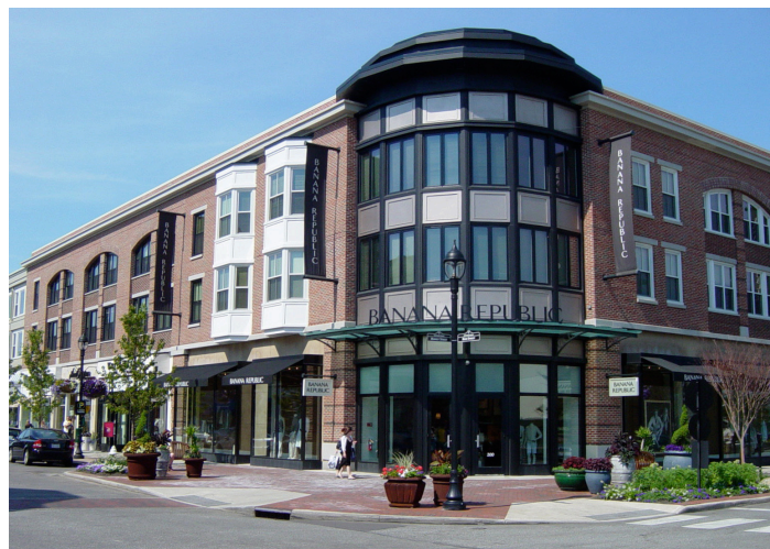
Bâtiment d'angle qui encadre deux rues par son volume, sa ligne de toit, ses matériaux et son entrée.
