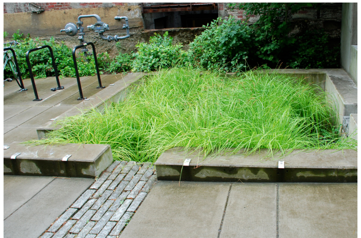
Bordure inclinée facilitant l'écoulement des eaux pluviales vers une aire végétalisée, Portland (Oregon)
