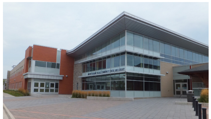
Exemple d'utilisation d'éléments architecturaux pour signaler des équipements collectifs emblématiques
