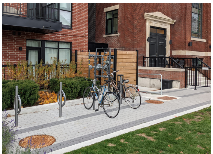
Écran et végétation entourant des compteurs de gaz
