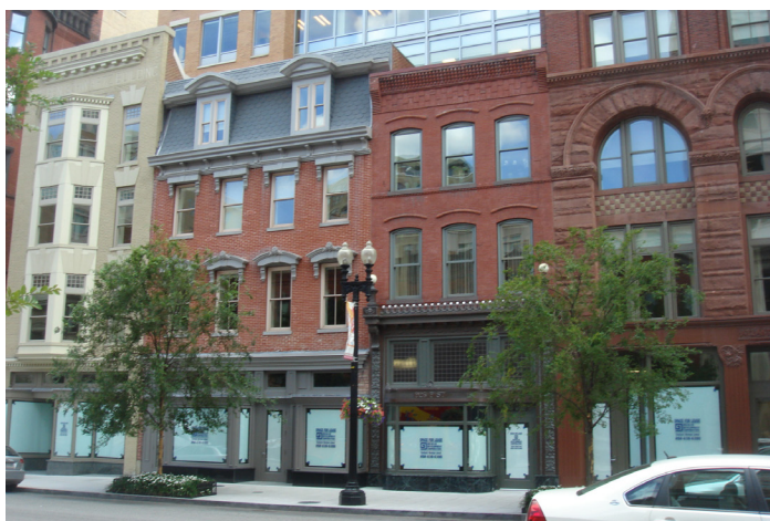
Façades conservées d'un vaste projet de réaménagement
