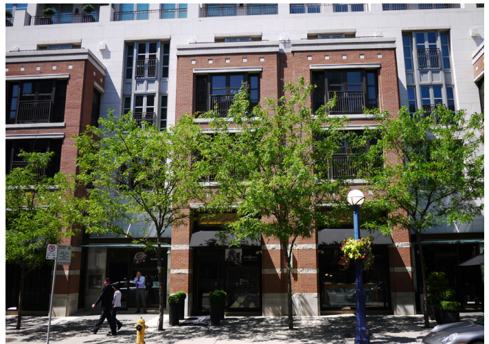
Exemple d'un bâtiment présentant des éléments de rythme vertical prononcés
