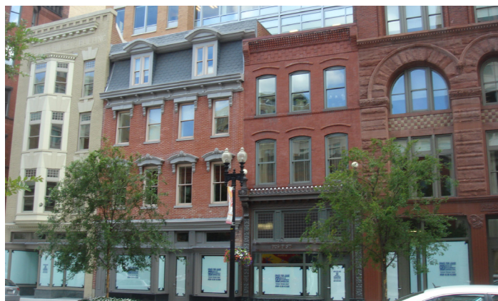
Façades conservées d'un vaste projet de réaménagement
