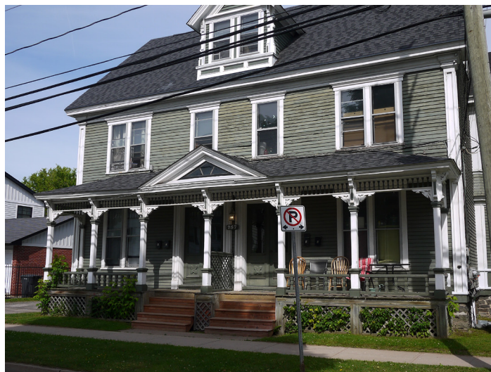
Porche d'un immeuble à logements multiples
