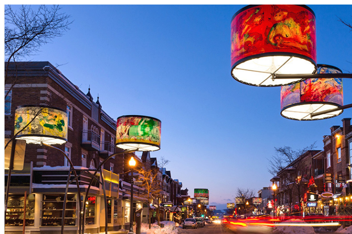
Installation d'éclairage de l'avenue Cartier par Lightemotion, Québec
