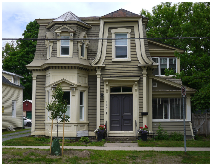
Détail d'entrée historique
