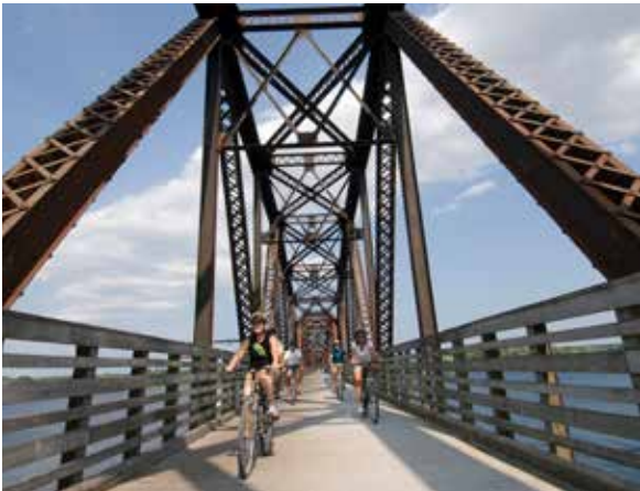
Pont piétonnier Bill Thorpe
