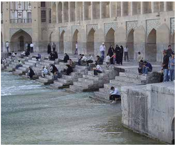
Exemple d’immeuble adapté à sa situation au bord de l’eau
