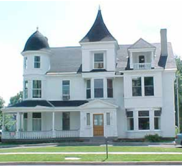
Forme bâtie résidentielle
