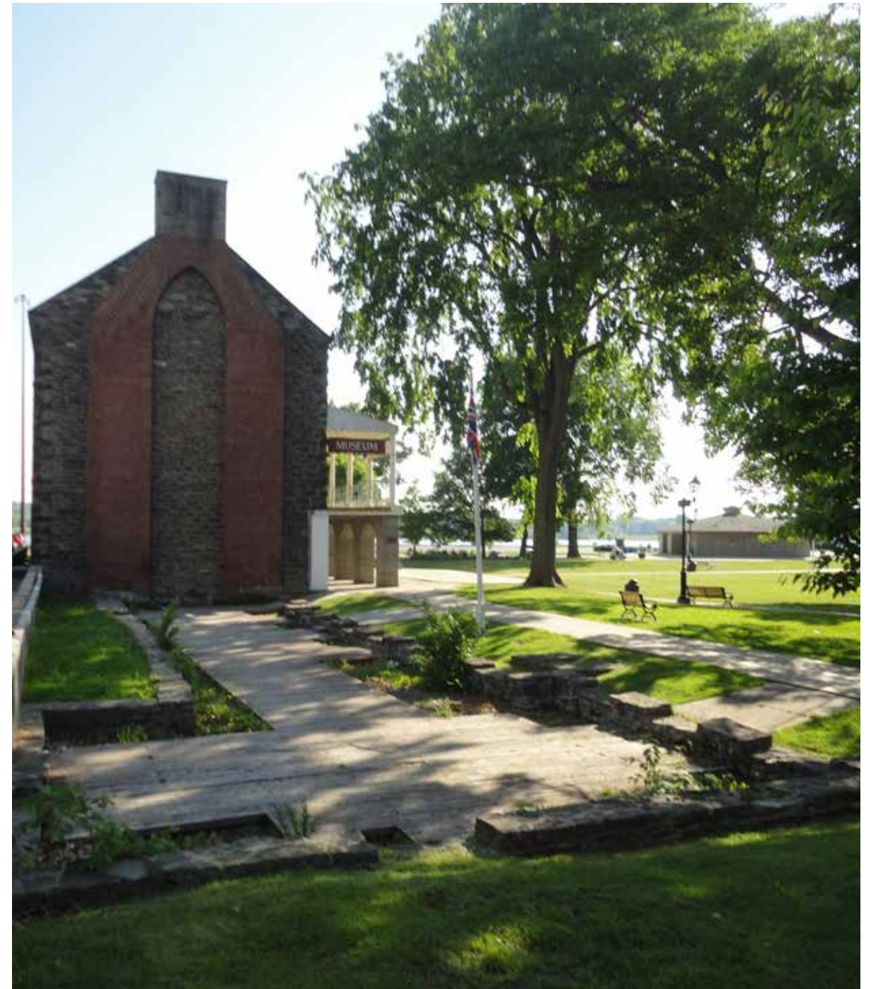
Vestiges de fondations à côté de la caserne en pierre dans le quartier de la garnison
