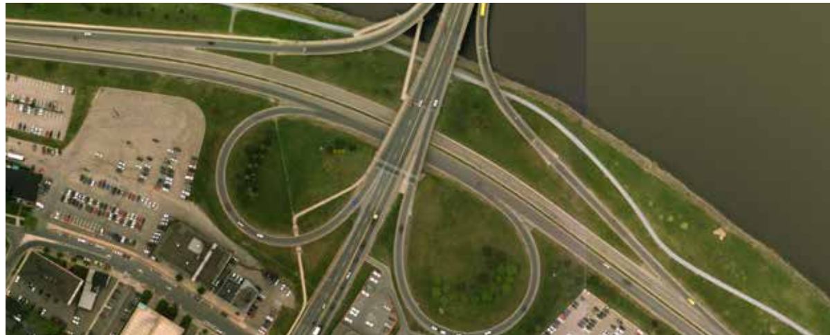
Pont de la rue Westmorland et bretelles d'accès
