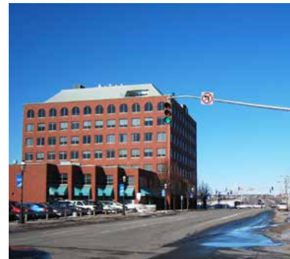
Vue de Frederick Square le long de la rue Westmorland
