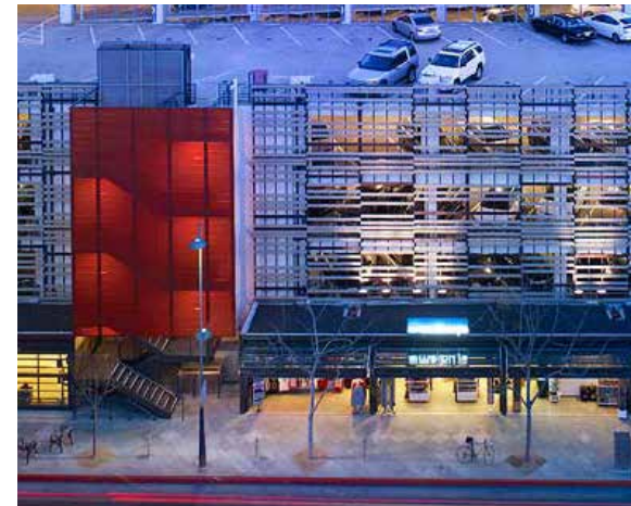
Exemples de stationnements en élévation
