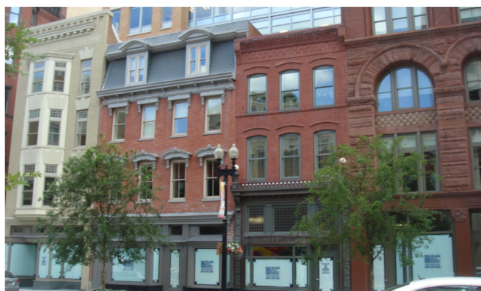
Façades conservées d'un vaste projet de réaménagement
