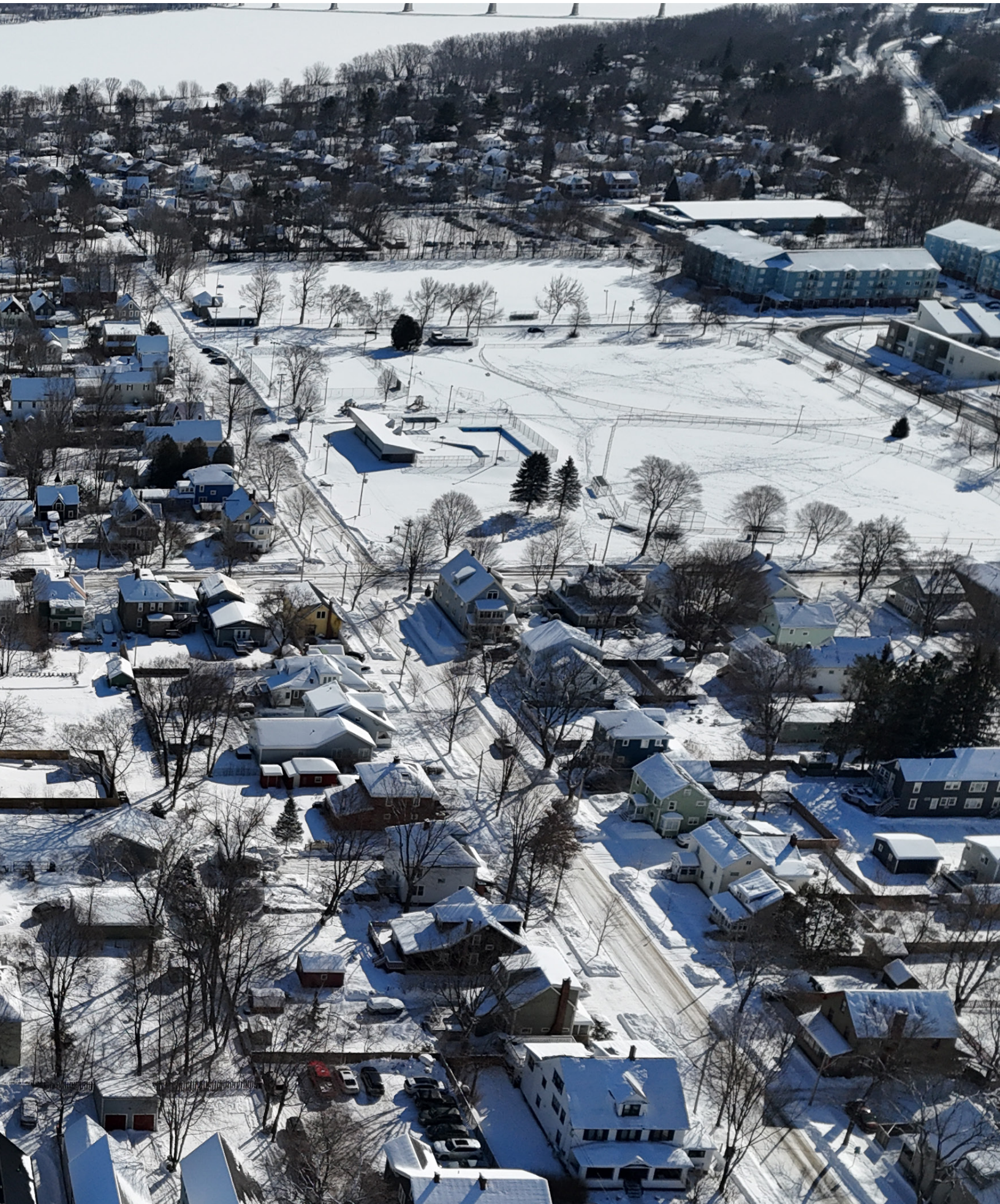
Photographie aérienne du parc de la place Queen
