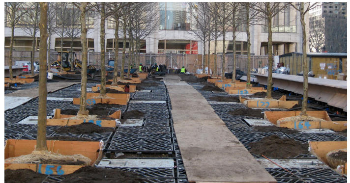
Installation de cellules de sol autour de Lincoln Center, New York (Source : DeepRoot sur Flickr.com)
