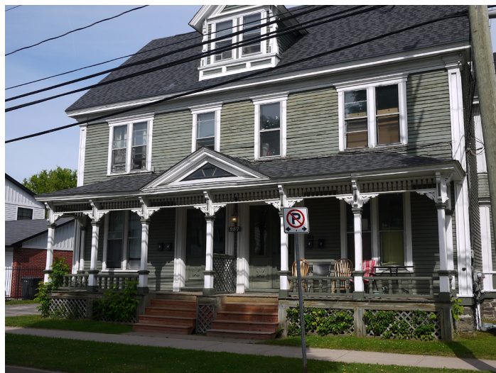
Porche d'un immeuble à logements multiples
