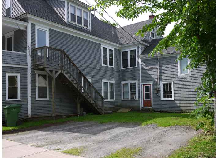
Entrée de logement secondaire en retrait
