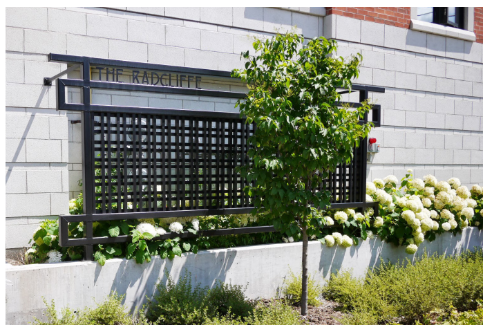
Dissimulation de compteurs à proximité de l'entrée d'un bâtiment
