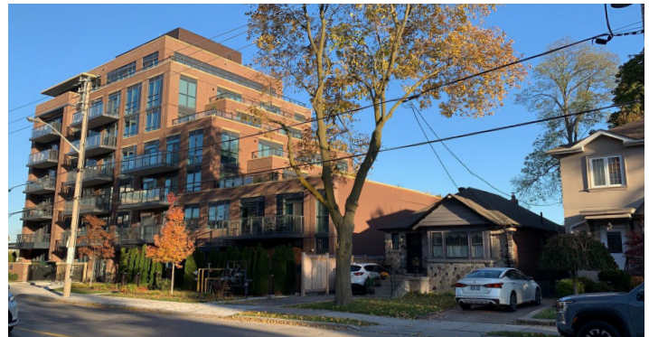
Bâtiment en dégradé pour créer une transition vers des habitations voisines de faible hauteur
