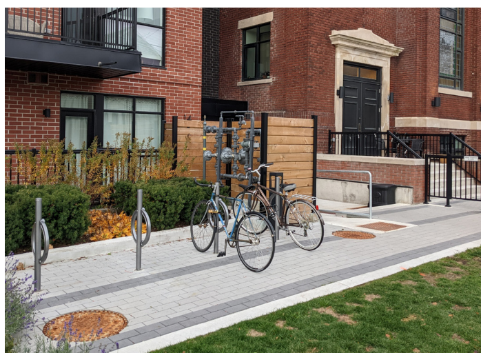
Écran et végétation entourant des compteurs de gaz
