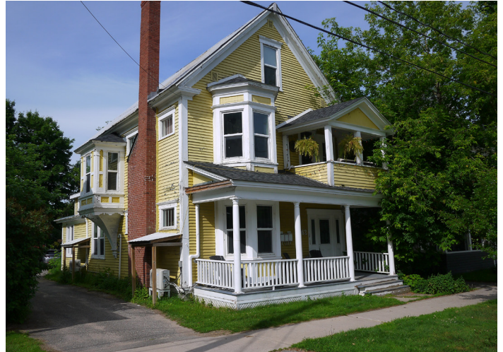
Mise en valeur du caractère historique et détails d'entrée
