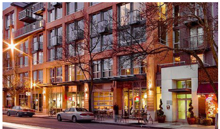
Entrée conduisant à des logements dans un bâtiment à usage mixte
