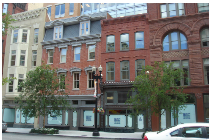
Façades conservées d'un vaste projet de réaménagement
