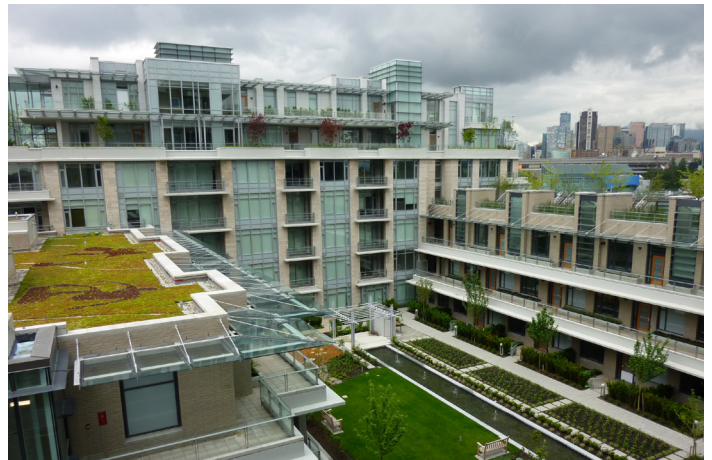
Toits végétalisés, lignes de toit intéressantes et installations techniques sur toit intégrées à l'architecture (image : Payton Chung, CC BY 2.0, Flickr)
