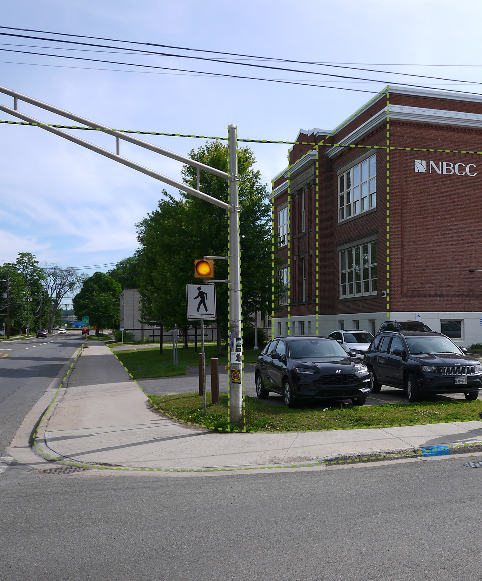
Édifice du New Brunswick Community College (rue Smythe)
