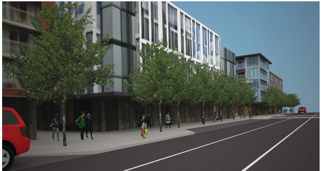
Aménagement à long terme (vers l'est)
