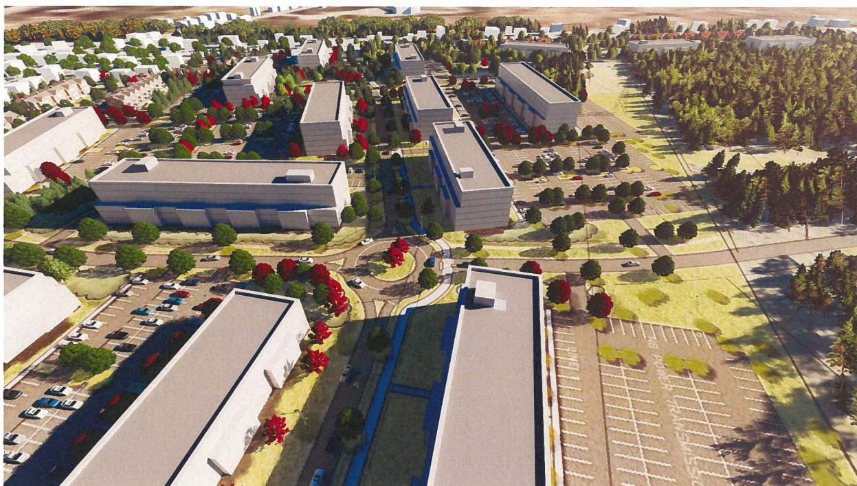
West view / vue Ouest
