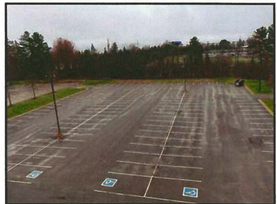
Parking north / stationnement nord
