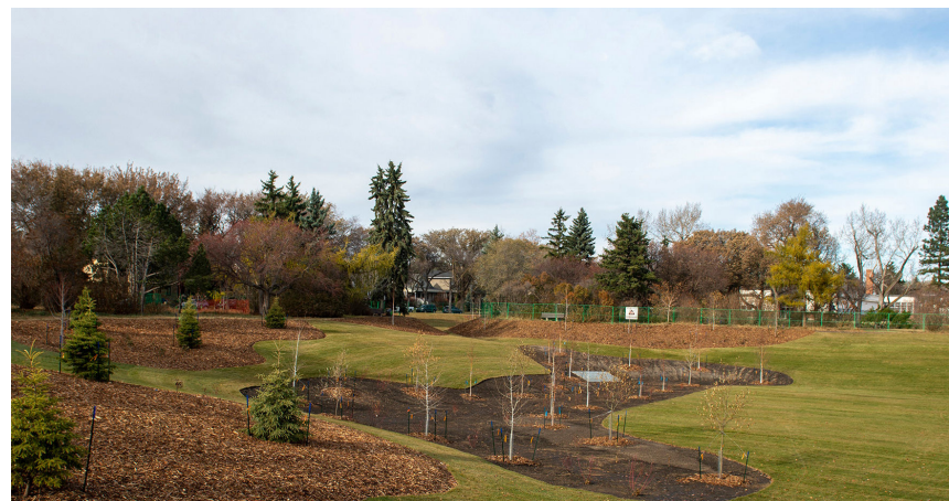
Figure 15 : Un parc conçu pour servir de bassin sec de rétention à Edmonton (Alberta) (Image : EPCOR)
